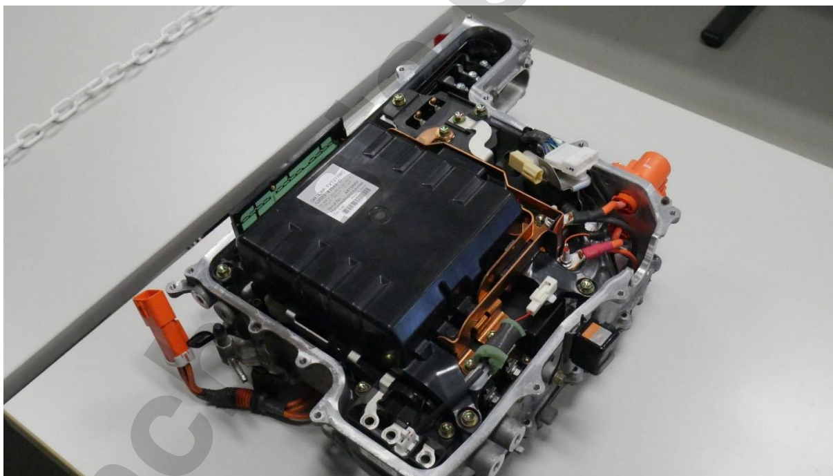
Figura 3-16 – Esempio di lavoro svolto su parti attive dentro l'inverter fuori tensione ed in sicurezza (scollegato dall'auto)
