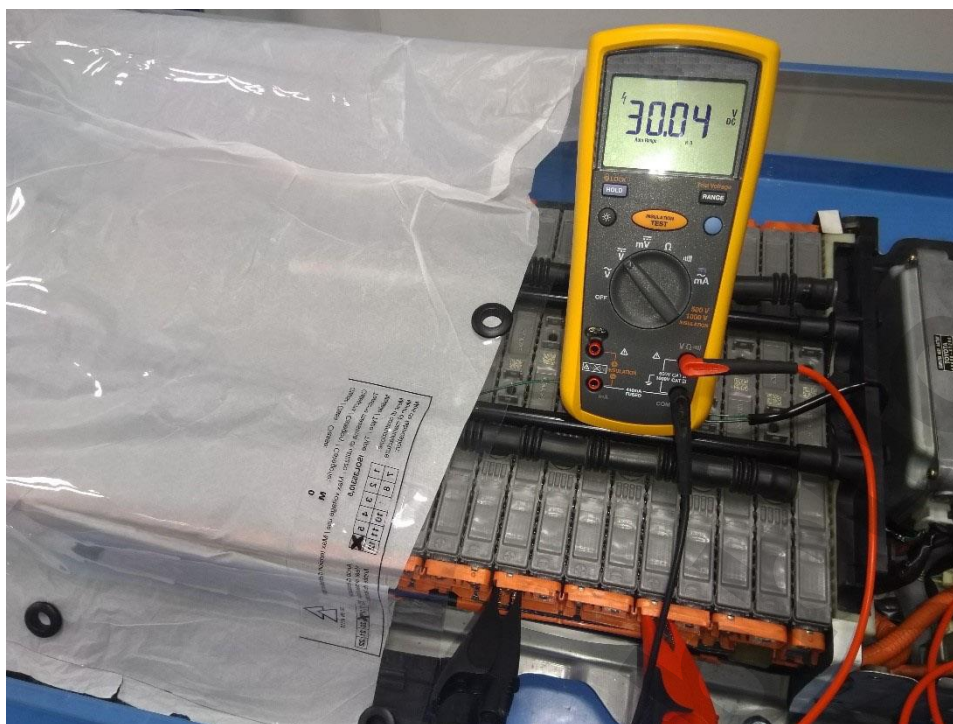
Figura 3-20 – Esempio di misura elettrica effettuata sulla batteria di trazione di un veicolo
